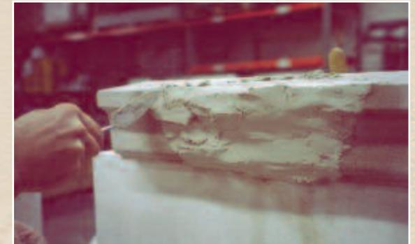
Realice la construcción de manera que abarque una superficie mayor a la construcción original (1/8" como mínimo).
