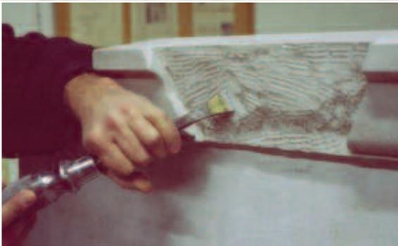
Corte un reborde de 1/2" alrededor de la reparación (LA REPARACIÓN NO DEBE TENER UNA APARIENCIA GRANULADA).
