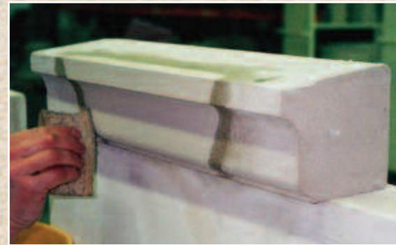
Luego del emparejado y texturado final, limpie el contorno de la reparación efectuada con agua y una esponja, a fin de eliminar todo sobrante de argamasa del sustrato. No introduzca agua en la argamasa fresca. Repita la limpieza varias veces con agua limpia para evitar que se forme un "halo" alrededor de la reparación.
