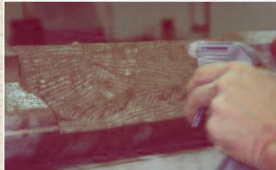
Humedezca el sustrato con agua hasta que las superficies verticales queden bien mojadas y no se acumule agua en las superficies horizontales. Los sustratos muy porosos se deben humedecer varias veces. **Si se deja secar la superficie antes de aplicar la argamasa Jahn, se deberá repetir este paso. Esto es muy importante.**
