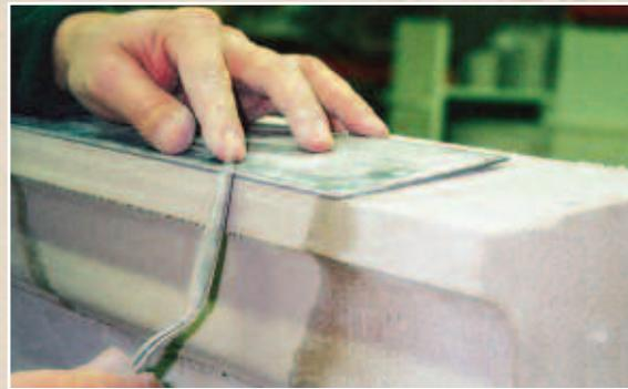
Para lograr el mejor resultado, espere hasta que la argamasa Jahn adquiera una consistencia de arena ligeramente húmeda antes de hacer la capa final. La argamasa no debe adherirse a la herramienta con que se realiza el acabado. Si la carpeta se realiza antes o después de lo que corresponde, el color final se verá afectado.
